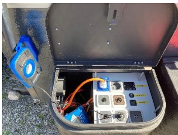
Bild Heizung 230V
